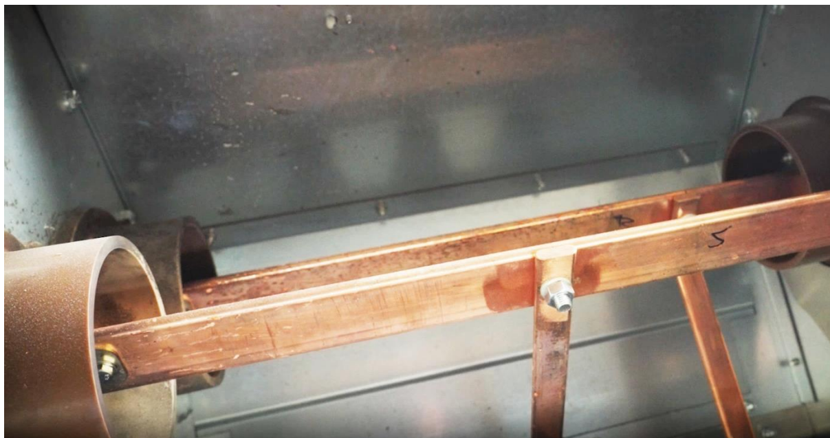
Rys. 15. Wnętrze przedziału szynowego rozdzielnicy D-17 po przeprowadzonej próbie z załączonym zabezpieczeniem łukoochronnego ArcPRO-6
